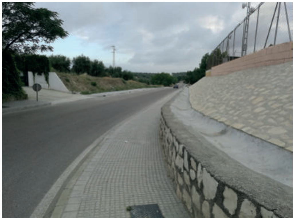
Acerado Entrada a Bujalance
