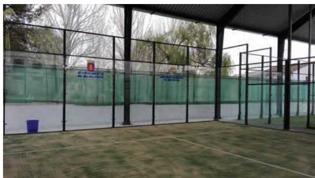
Techado de las Pistas de Pádel
