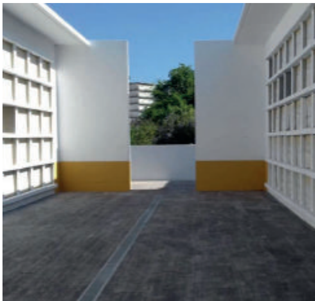
Acondicionamiento y ampliación del Cementerio Municipal
