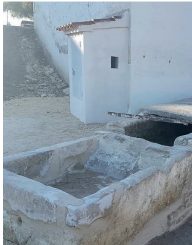
Implantación de un sistema de bombeo y mejora del Pozo de la Noria de Consolación
