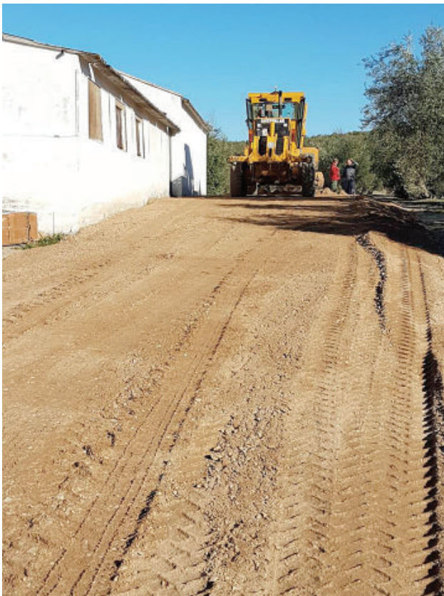
Arreglo del Camino de la Fuente del Chorro y paso de aguas
