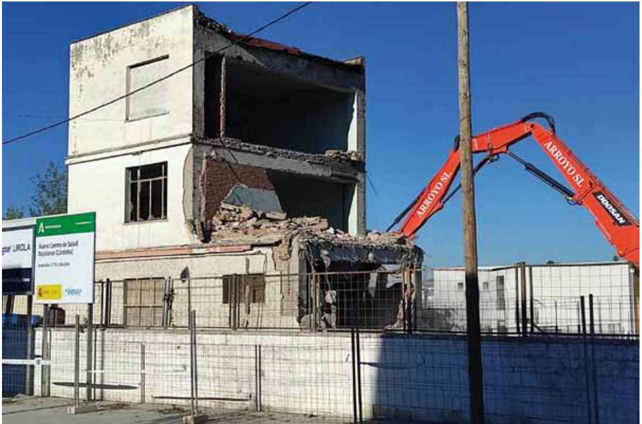
Empiezan las obras del nuevo Centro de Salud
