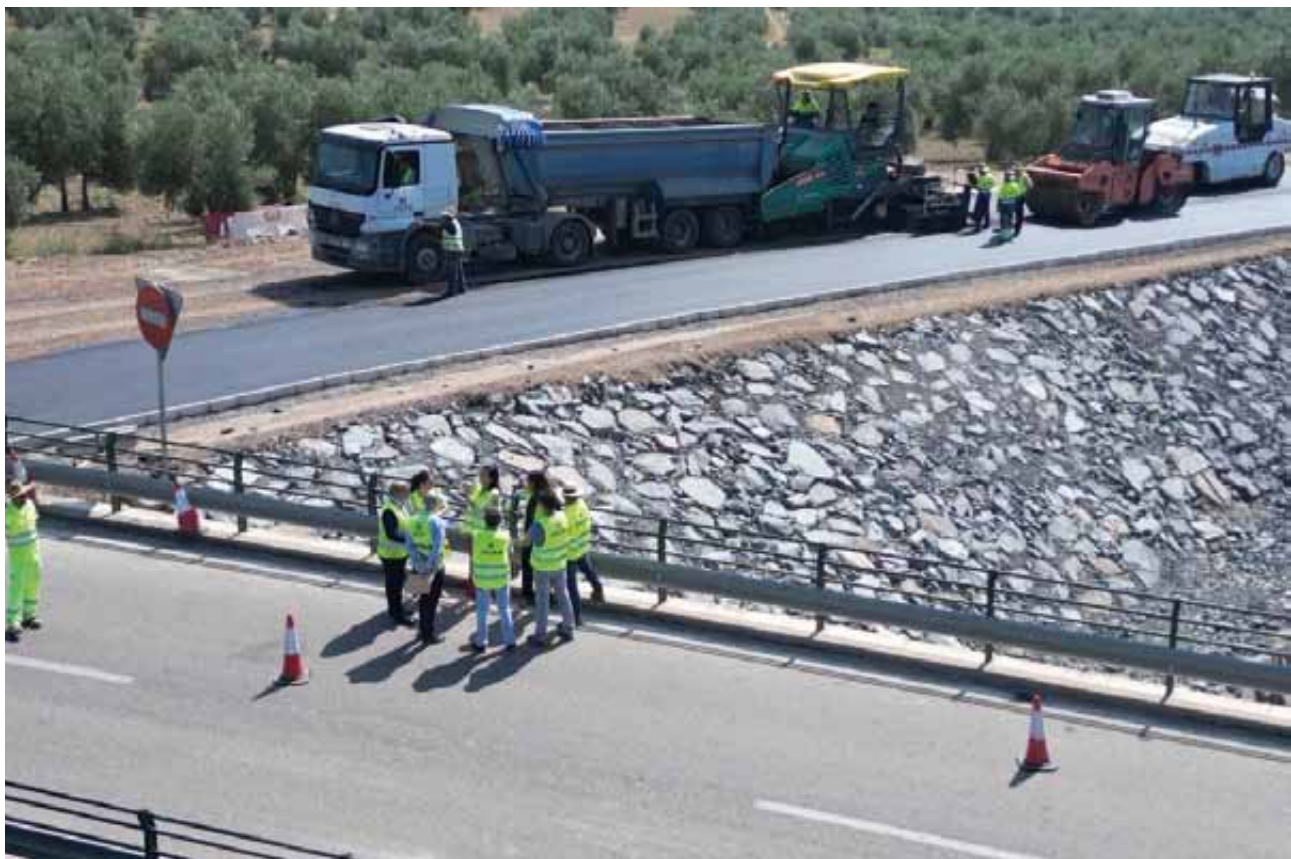
Mejora del firme y acceso a la A 306
