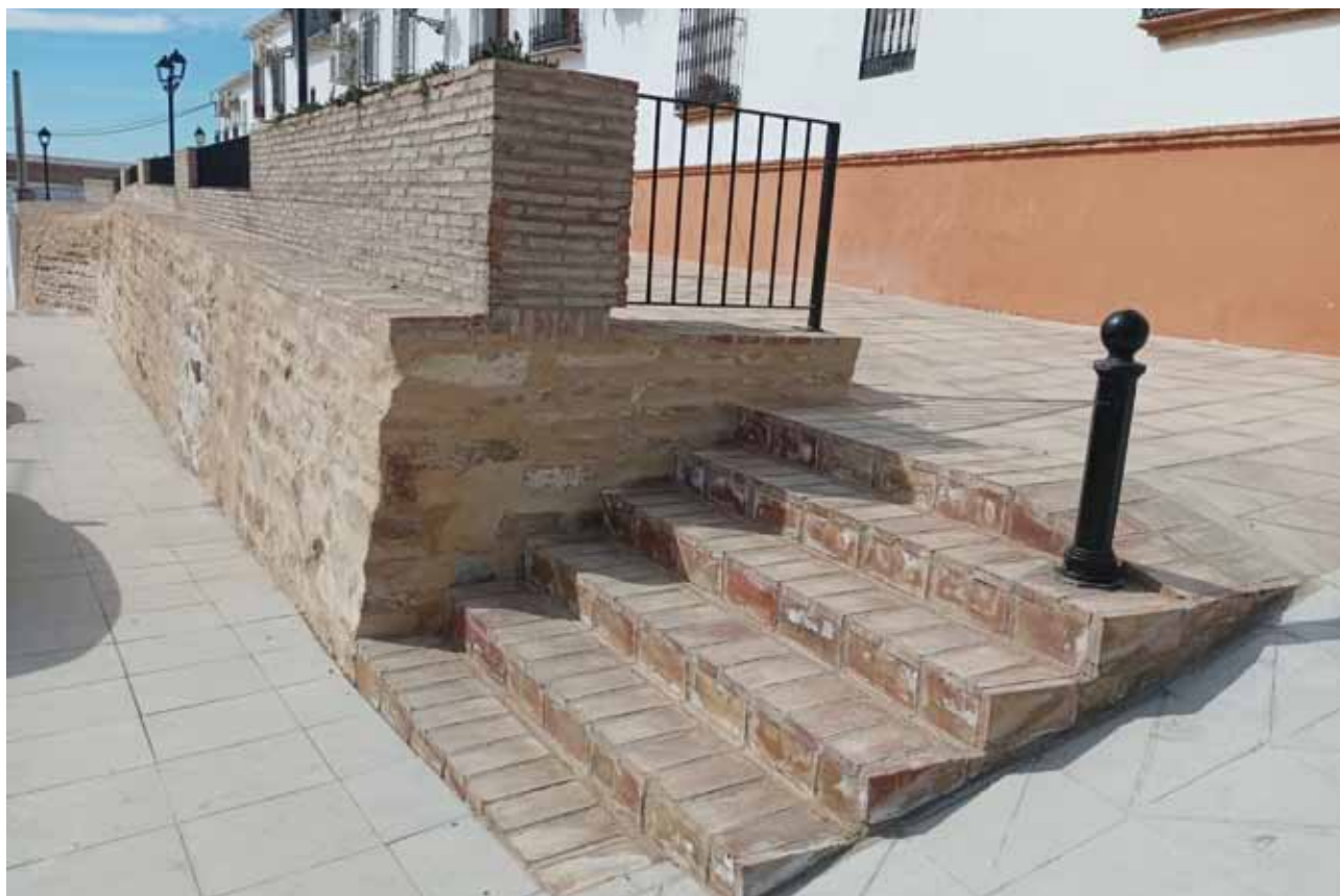
Obras en la calle San Pedro
