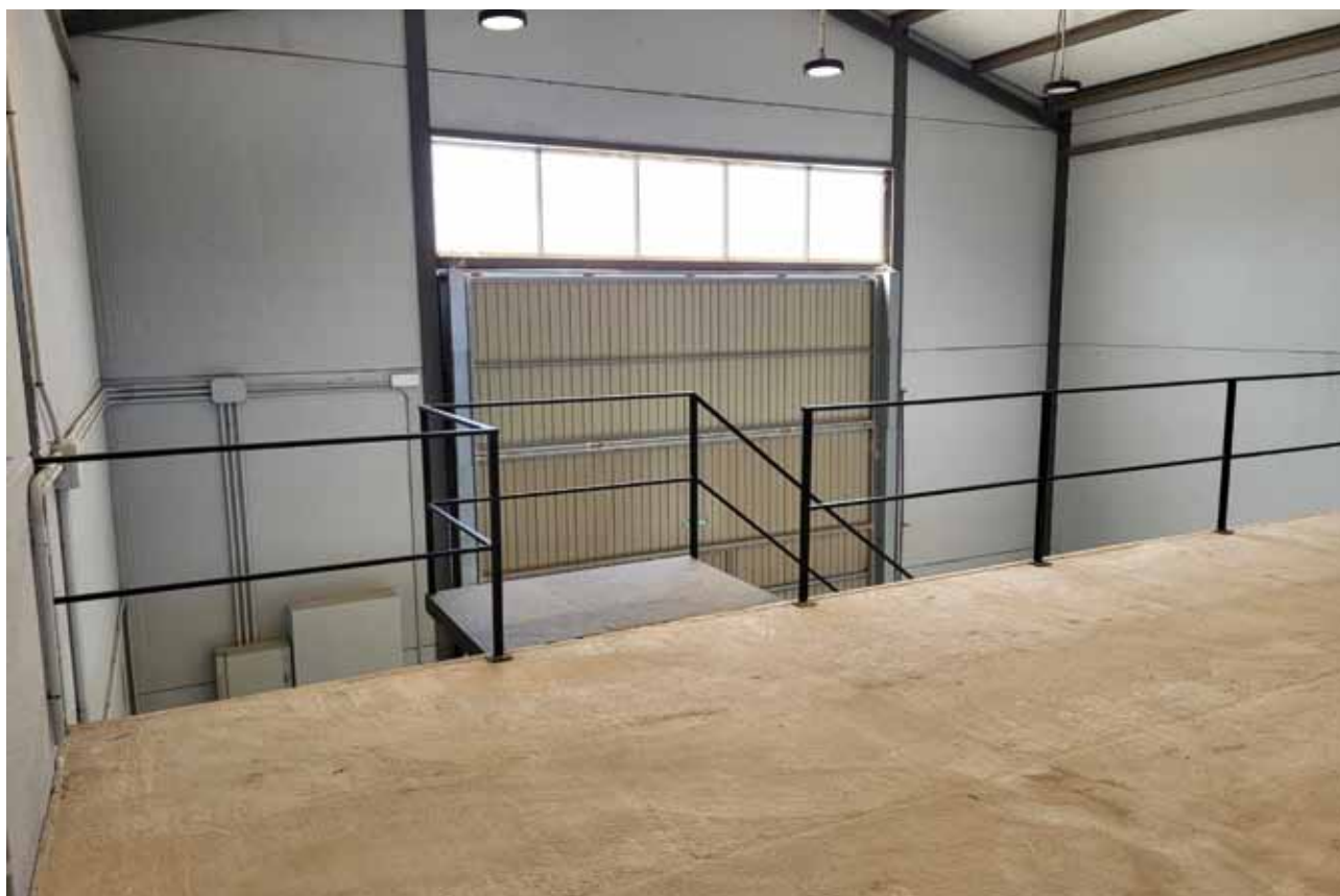
Remodelación de las naves municipales para el traslado del personal de mantenimiento
