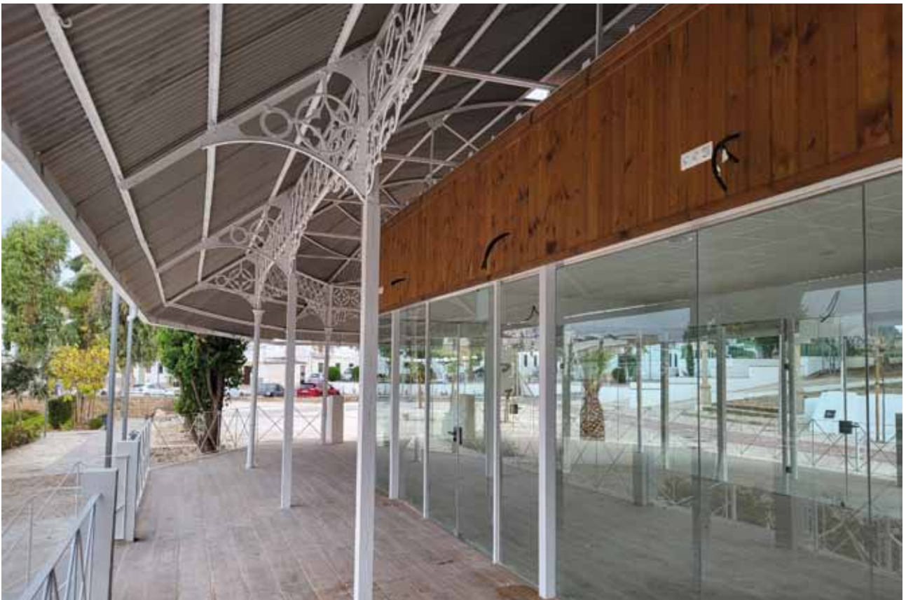
Remodelación de Pérgola en Parque Antonio Bermúdez "El Jardinero"
