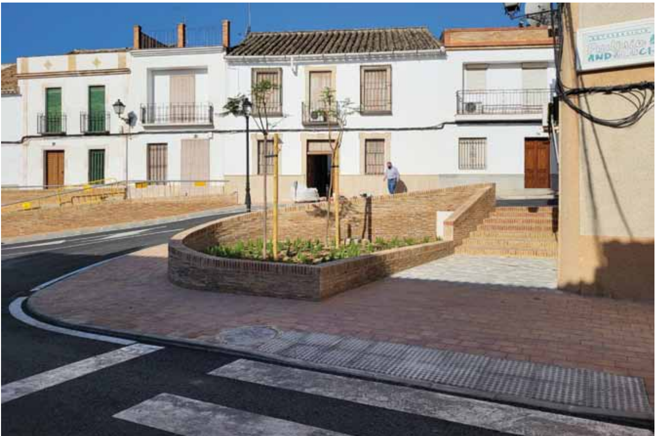
Obras en Avda. Doctor Fleming
