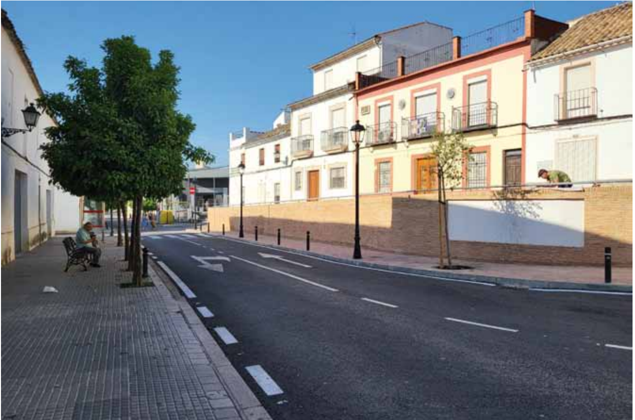
Obras en Avda. Doctor Fleming
