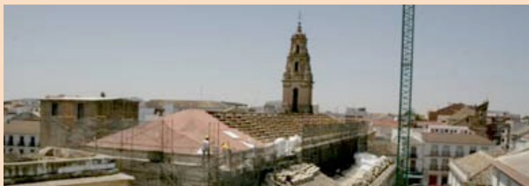
Figura 4: Vista del Templo Parroquial de San Francisco durante las obras de restauración de la cubierta, y en la que puede apreciarse el horizonte de poniente.
