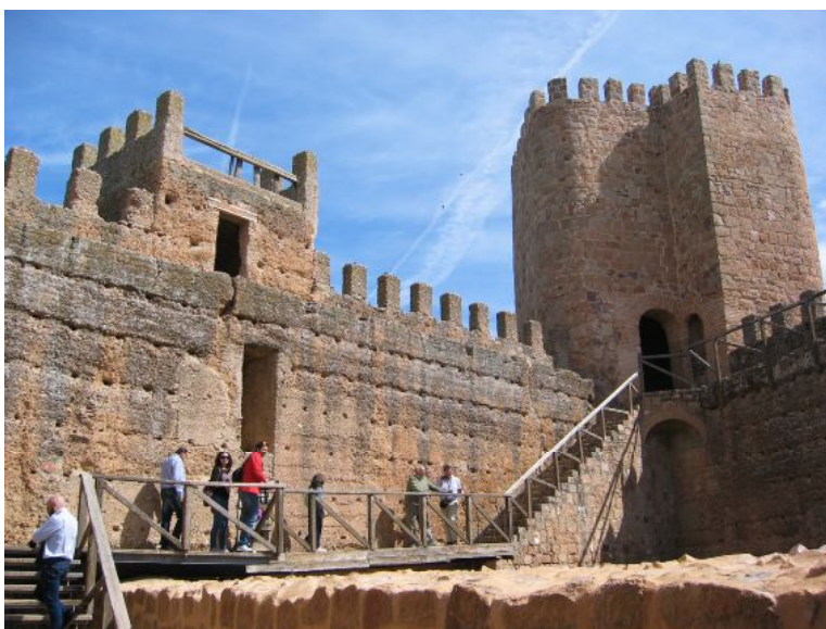
Acceso a la Torre del Homenaje
