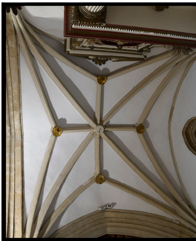
Bóvedas capillas laterales
