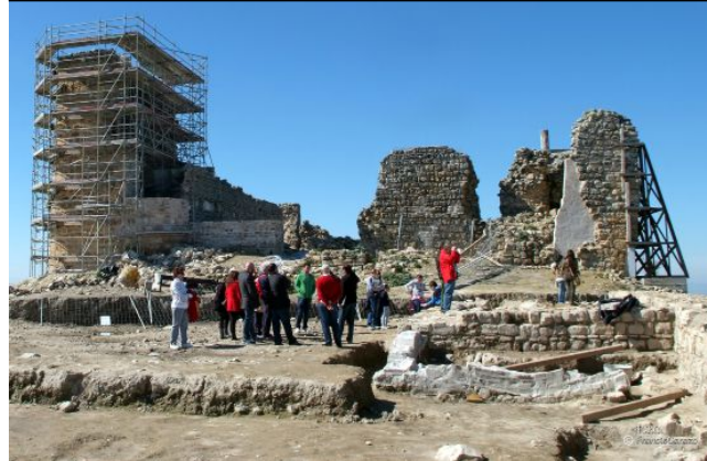
Obras del Castillo de Torreparedones
