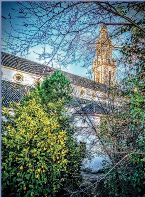
Vista del solar desde calle M Mantilla, antigua calle Carnicerías.
