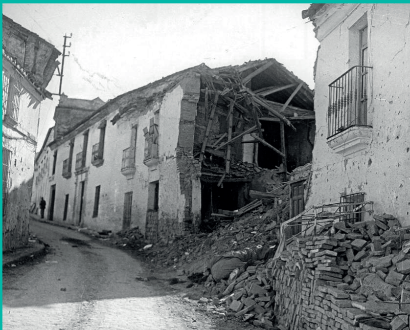
Calle Fernando Notario, vivienda demolida por bomba.
