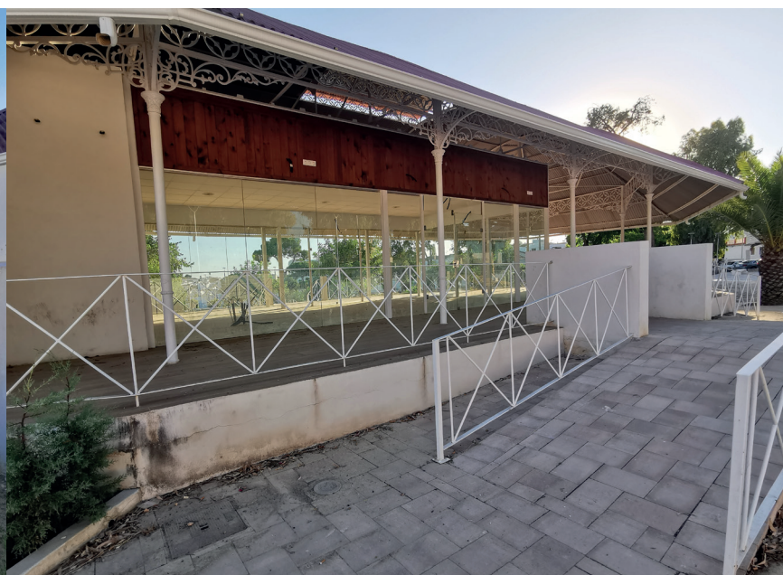
Pésima restauración del templete centenario del parque
