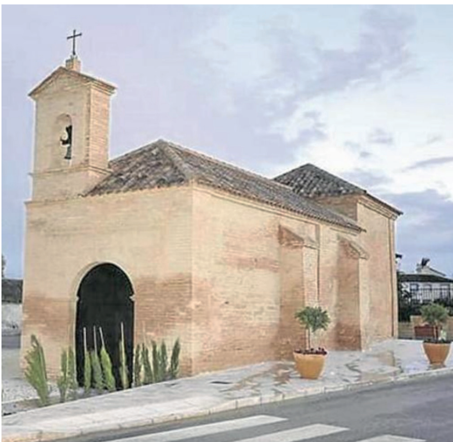
Ermita de Consolación, 1970 - 2019 La amenaza de ruina ha sido revulsivo en su recuperación: Simbólico indicador para otras tareas
