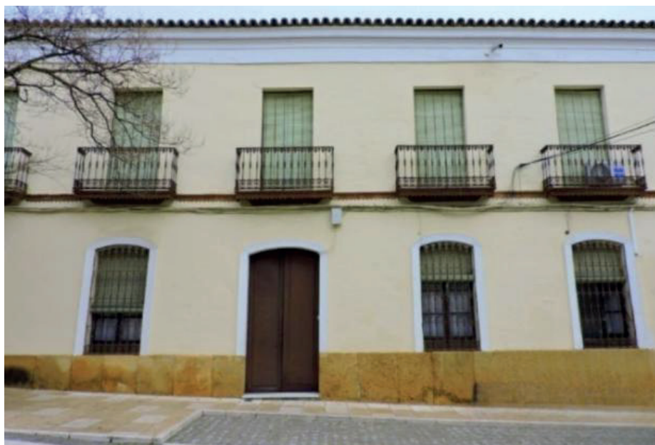
Casa del poeta Mario López. Fue utilizado como improvisado cuartel por las tropas republicanas de Pérez Salas durante los primeros meses de la guerra, y en su fachada, pueden apreciarse numerosos impactos y cortes en las rejas metálicas de las ventanas, debido a esquirlas de metralla.
