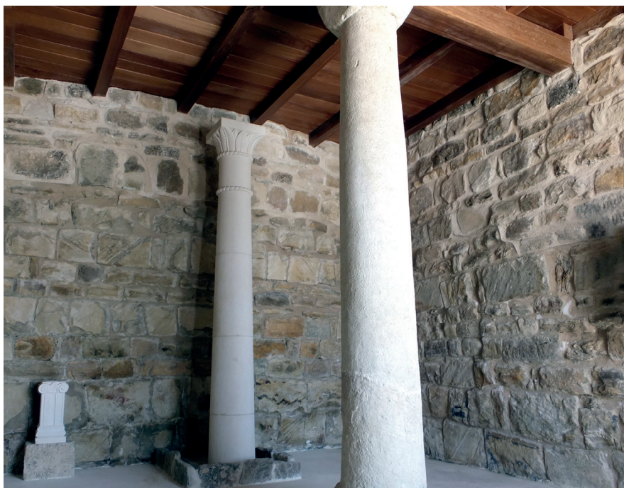
Lám. 3. Estado actual de la cella del santuario después de la restauración, con la columna arquitectónica en primer lugar y al fondo, el betilo sagrado estiliforme
