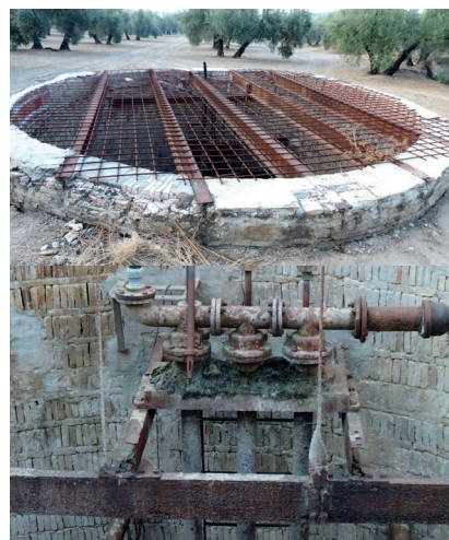
Pozo emisario de la Casa del Agua y restos de la bomba
