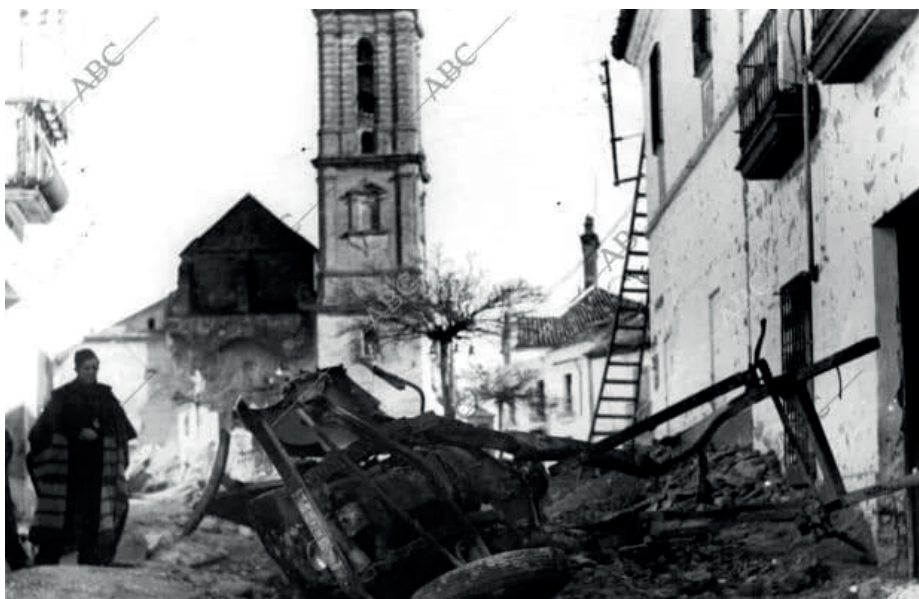
Calle San Pedro, socavón producido por la caída de una bomba. Foto: Serrano
